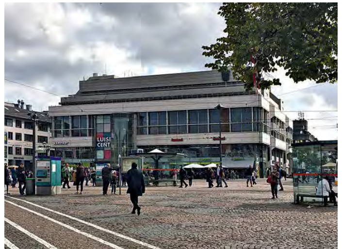
Ist-Zustand: Leerstand an innerstädtischem Knotenpunkt • Current status: Vacancy at inner-city junction
